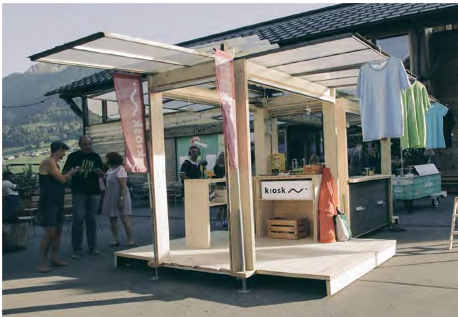
Der Wanderkiosk ist ein modularer Freiraum. Er kann in aller Einfachheit aufgebaut, abgebaut und benutzt werden. Seine Einsatzmöglichkeiten sind kaum begrenzt. Der Holzbau ist klapp- und erweiterbar und kann als Bühne ausgeklappt und als Ausschankbude umgeklappt werden. Seine vier Seiten können, je nachdem, wie man ihn braucht, auf allen Seiten separat geöffnet und geschlossen werden. Er ist eine **Bühne**, ein **Verkaufsstand**, ein **Infoplatz** und auch ein **Strassencafé**.
